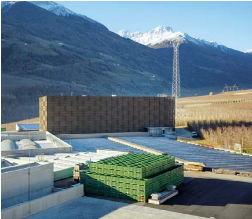
Das neue Hochregallager dient als Puffer zwischen CA-Zellen, Sortierung und Verpackung.
